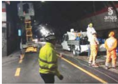
I lavori nella galleria della Limina
