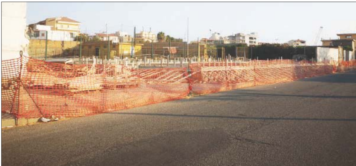
Lavori sospesi al campo sportivo di Pellarò
