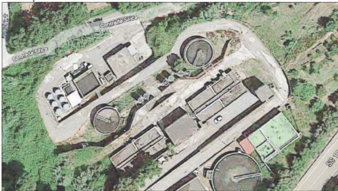
Il depuratore di località “Silica”
