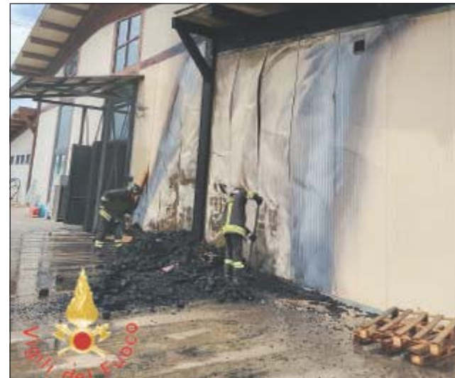
La parte esterna del capannone
