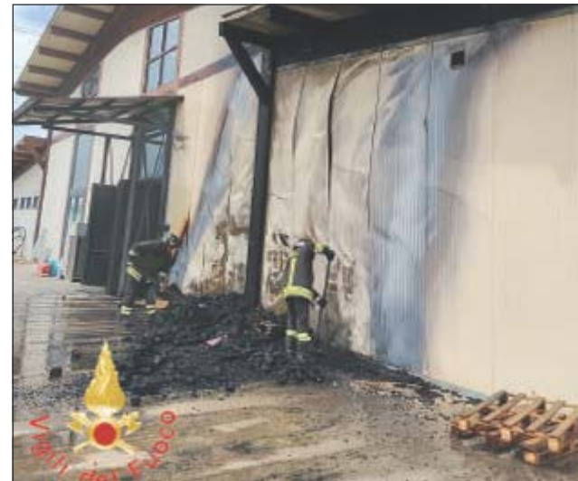
La parte esterna del capannone
