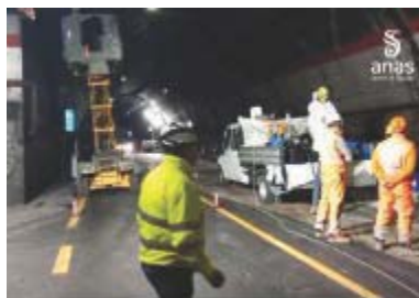
I lavori nella galleria della Limina
