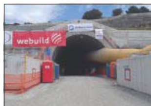
Lavori del terzo megalotto
