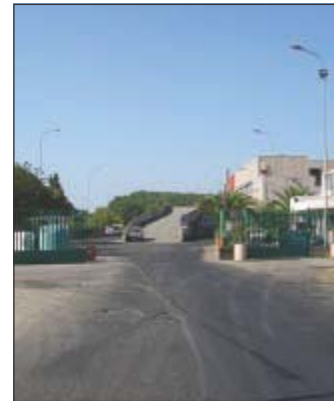
Il depuratore di Coda di Volpe
