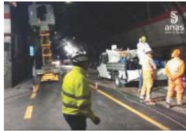
I lavori nella galleria della Limina
