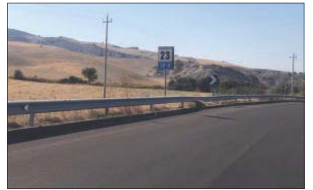
Lavori di messa in sicurezza sulla Cavonica
