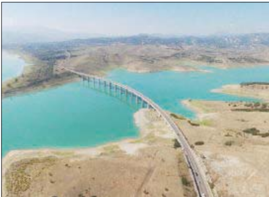
La diga di Monte Cotugno
