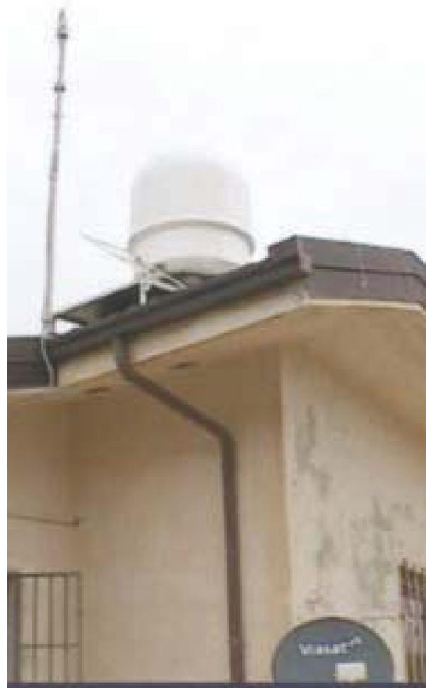
Un radar montato per monitorare le condizioni meteo
